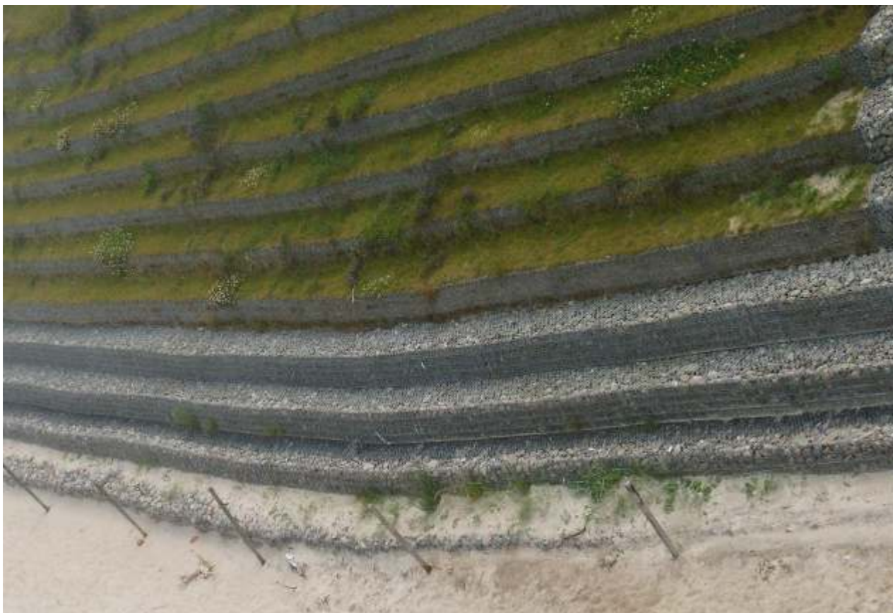
umocnienie brzegu - Bałtyk
